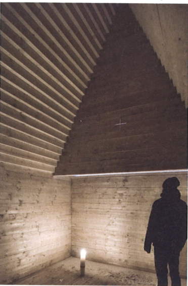
Ein 63 Grad steiler Giebel A gable 63 degrees steep
