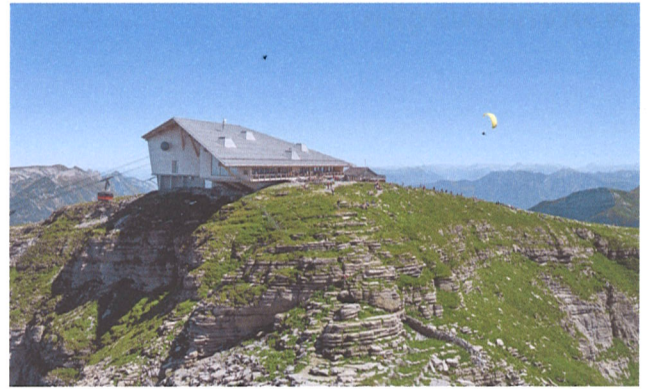
Bergbahnstation und Restaurant Chäserrugg, Alt St. Johann (CH) Architektur: Herzog & de Meuron, Basel
