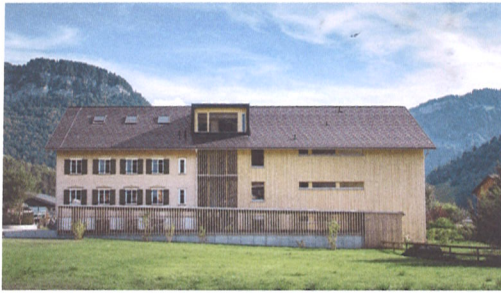
Sanierung und Neubau «Haus mitanand», betreutes Wohnen und Kita, Bezau (A) Architektur: Hermann Kaufmann, Schwarzach
