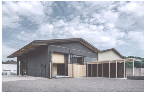
Sanierung des Bürohauses PCT Loftbüro, Thalgau (D) Architektur: Atelier dunkelschwarz ZT OG, Hannes Sampl, Michael Höckestaller, Salzburg
